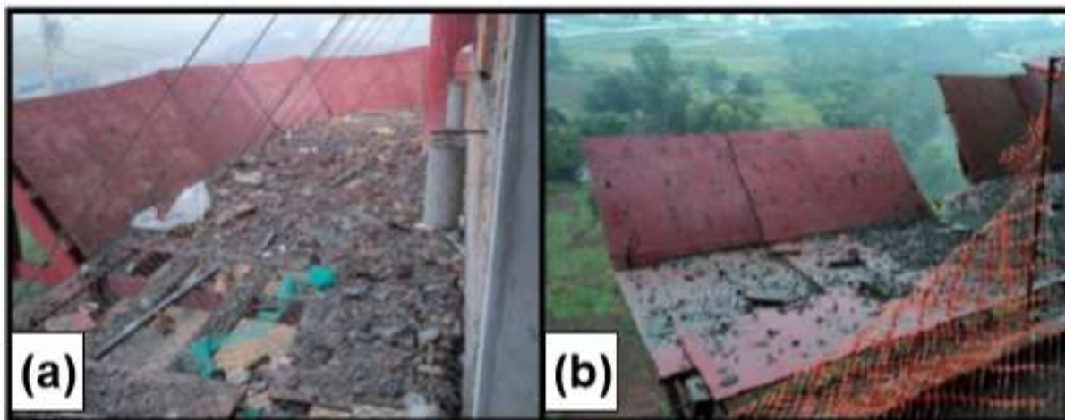
Figura 6 - Bandeja principal de contenção Empreendimento A (a) e B (b).
