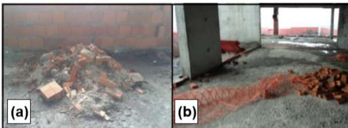
Figura 1 - Segregação dos resíduos classe A por pavimento para os empreendimentos A (a) e empreendimento B (b).
