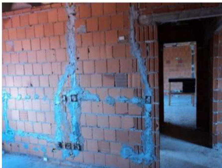
Figura 8 - Recortes feito na parede para instalação da rede elétrica e após o preenchimento com argamassa. Fonte: Imagens cedidas pela empresa
