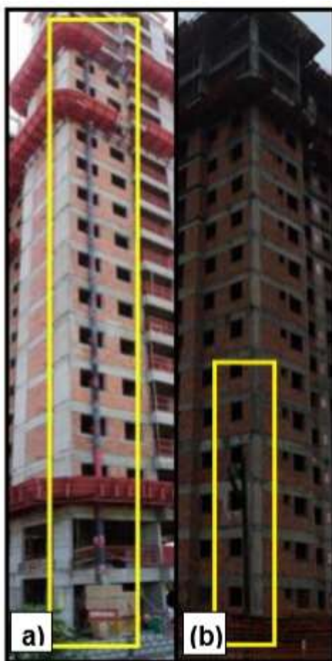
Figura 3 - Duto nos pavimentos para Empreendimentos A (a) e B (b) Fonte: Imagens cedidas pela empresa
