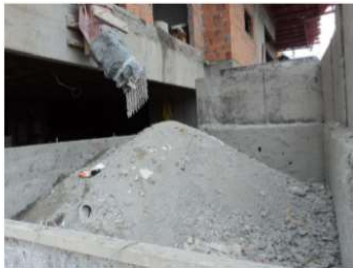
Figura 4 - Caçamba de destinação final de resíduo classe A no empreendimento A.
