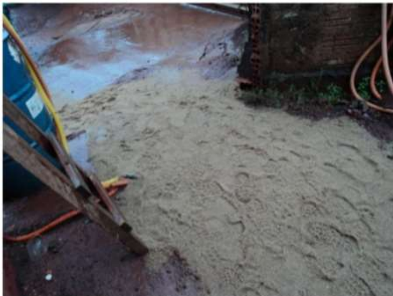
Figura 7 - Utilização excessiva de areia em casos de chuvas constantes, empreendimento A. Fonte: Imagens cedidas pela empresa
