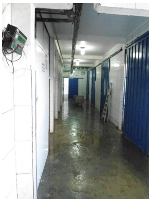
Figura 1 - Corredor de acesso aos caminhões e câmaras frias.
