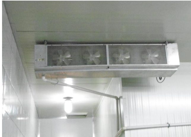
Figura 9 - Equipamento de ventilação.
