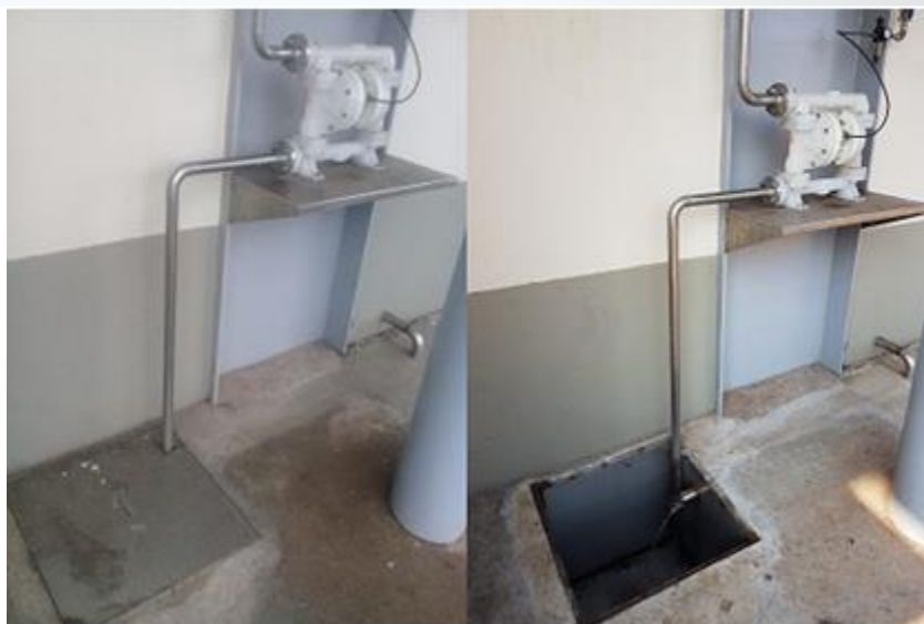
Figura 10 –Água reaproveitada das canaletas e bombeada para Torre de Resfriamento Fonte: Empresa
