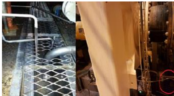
Figura 8 – Água de refrigeração do selo da bomba Sulzer antes e depois dos reaproveitamentos
