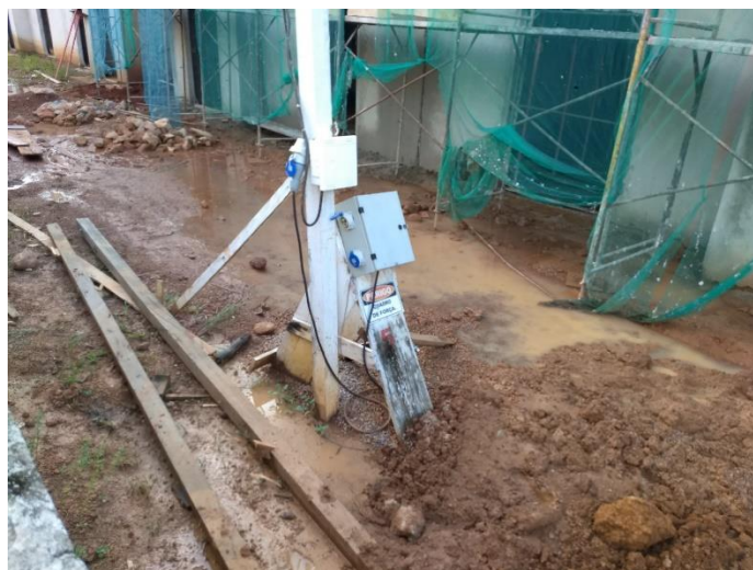
Figura 9 – Instalações Elétricas: Canteiro “B”
