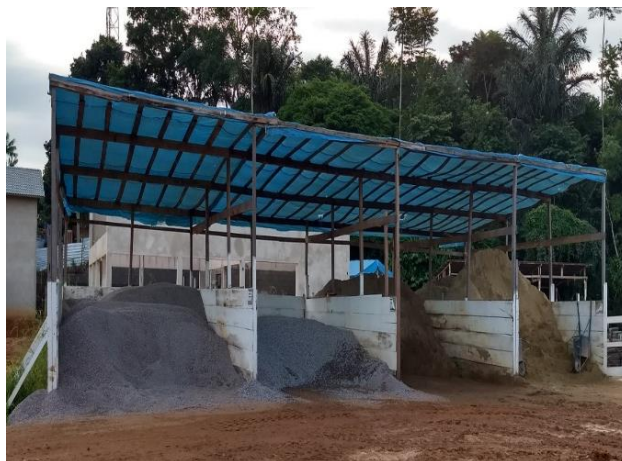
Figura 10 – Armazenagem de materiais: Canteiro “B”
