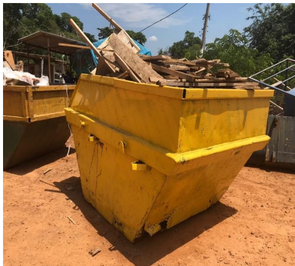
Figura 12 – Ordem e Limpeza: Canteiro “B”
