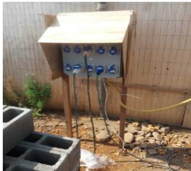
Figura 3 – Instalações Elétricas: Canteiro “A”
