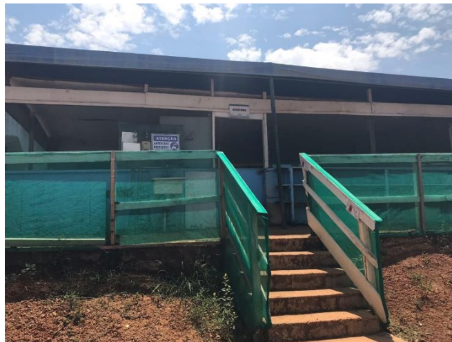
Figura 8 – Local de Refeições: Canteiro “B”
