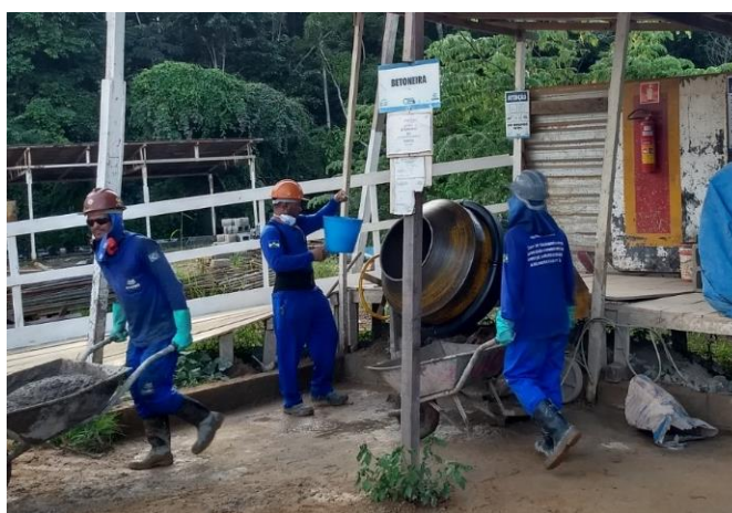
Figura 7 – EPI’S: Canteiro “B”
