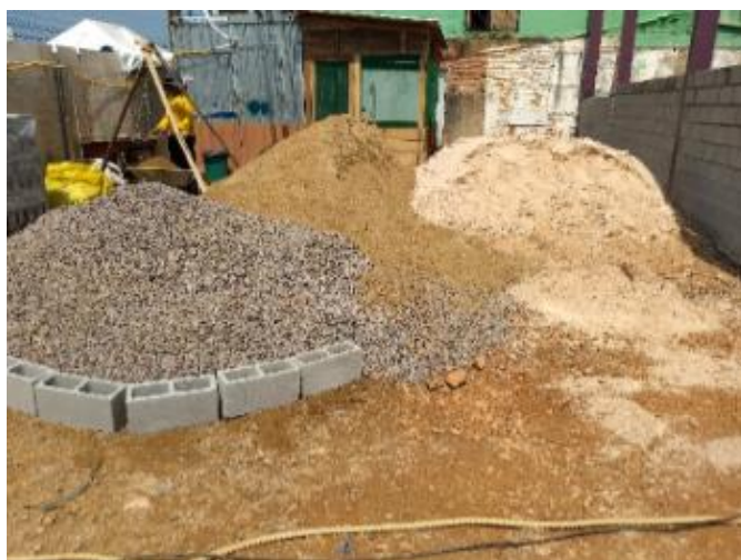
Figura 4 – Armazenagem de materiais: Canteiro “A”
