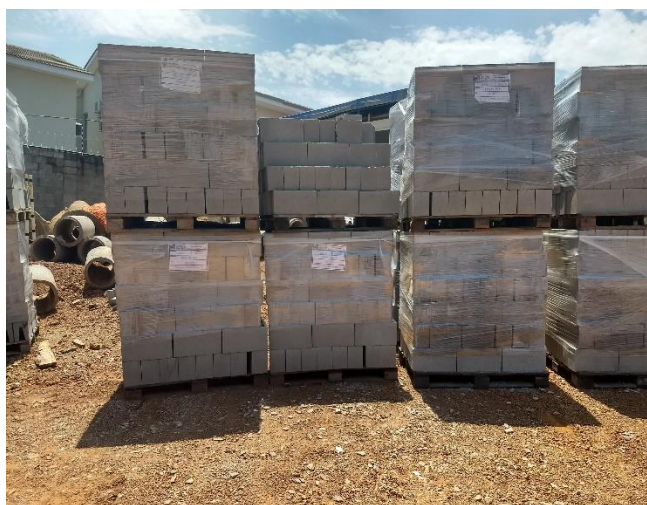
Figura 11 – Armazenagem de materiais: Canteiro “B”
