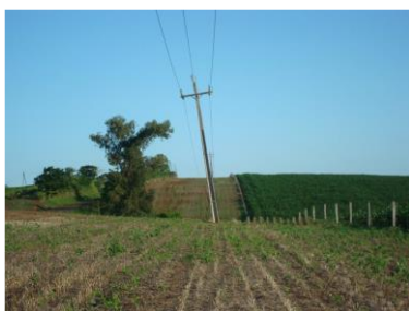
Figura 16. Poste fora de prumo.
