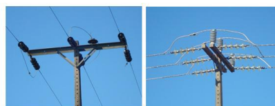
Figura 6. Estruturas de ancoragem antes (esq.) e depois (dir.) do reisolamento.
