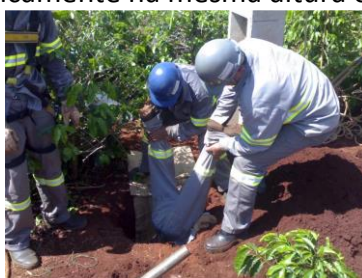
Figura 13. Queda em nível distinto
