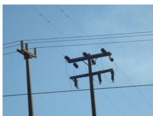
Figura 8. Cruzamento aéreo não interligado.
