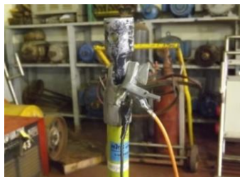
Figura 8. Conexão transformador e condutor nas luvas
