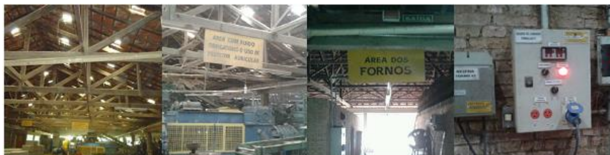
Figura 2 – Ambiente de Trabalho (iluminação, sinalização e painel de controle)
