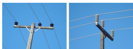
Figura 5. Estruturas de sustentação antes (esq.) e depois (dir.) do reisolamento.
