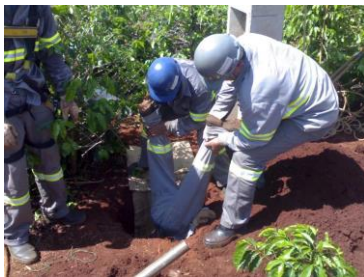
Figura 13. Queda em nível distinto
