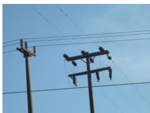
Figura 8. Cruzamento aéreo não interligado.
