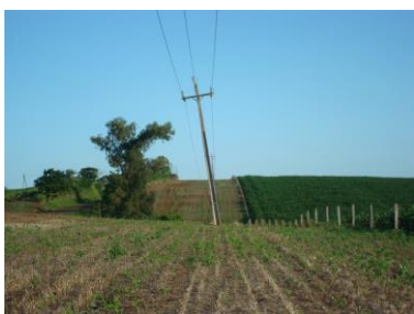
Figura 16. Poste fora de prumo.
