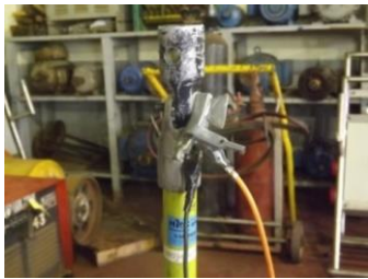
Figura 8. Conexão transformador e condutor nas luvas
