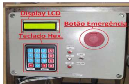
Figura 6: Painel de controle. Fonte: Própria
